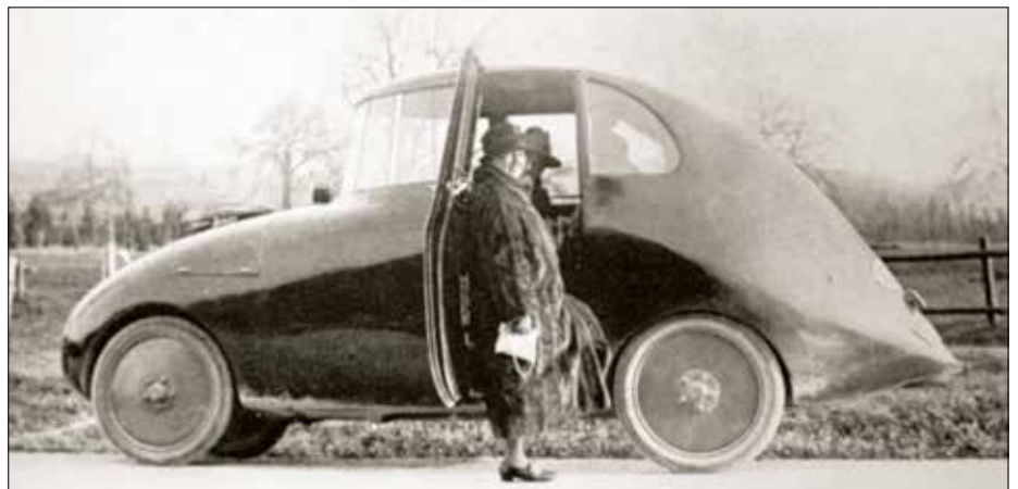
Ley T6, první realizovaný Jarayův proudnicový automobil z roku 1922. Z obrázku jsou patrné jeho značné rozměry
