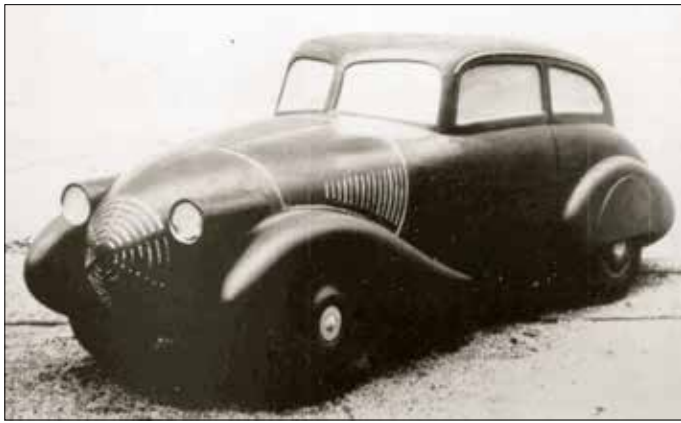
Nedatovaný dřevěný model proudnicové karoserie Wikow, patrně v měřítku 1 : 1
