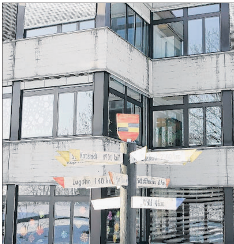
Auf dem Dach des Schulhauses Blatt wird eine Photovoltaikanlage gebaut. (Re)
